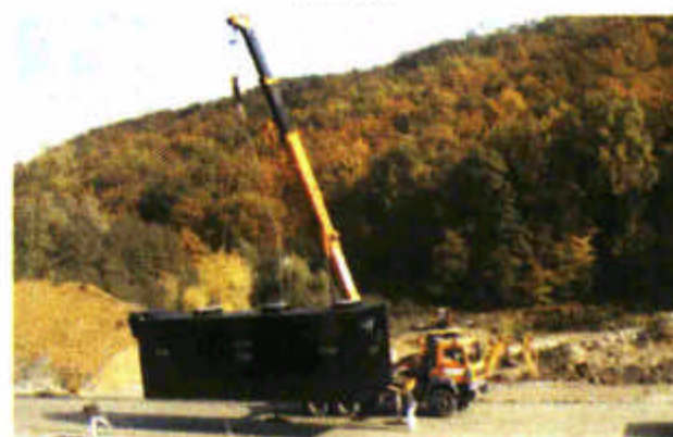
Istovar i ugradnja separatora
